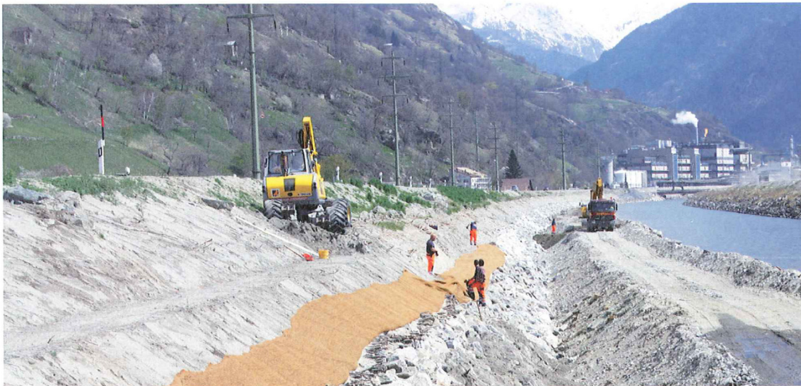
Die Rhone im Abschnitt der Lonza-Werke. Nach der Verstärkung der Dämme mit einer wasserdichten Wand wird der Fluss aufgeweitet. Hier wird am neuen Uferschutz gebaut: Steingrundierung im unteren Teil und eine Stabilisierung durch Vegetation im oberen, vom Fluss weniger beanspruchten Teil. Ganz oben ist andeutungsweise die neue Umfahrungsstrasse von Visp zu erkennen, deren Bau durch die 3. Korrektur erleichtert wurde.
