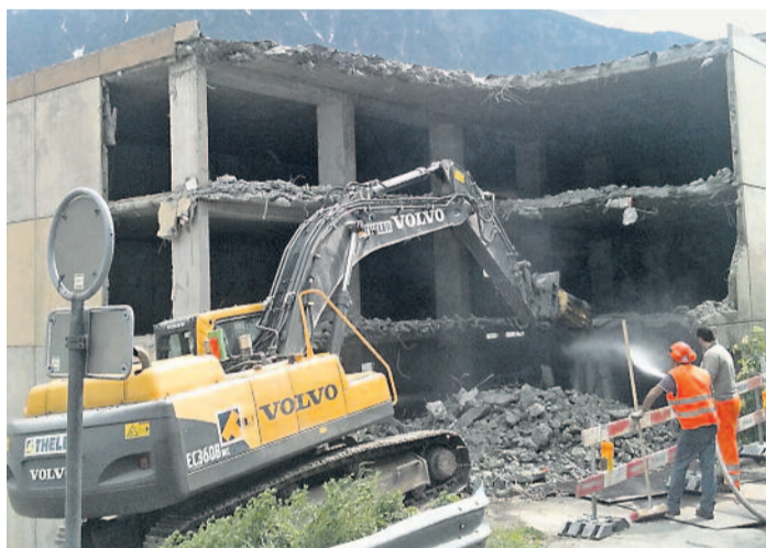
Bissig. Meter für Meter frisst sich der Bagger durchs ehemalige Gertschenareal.
