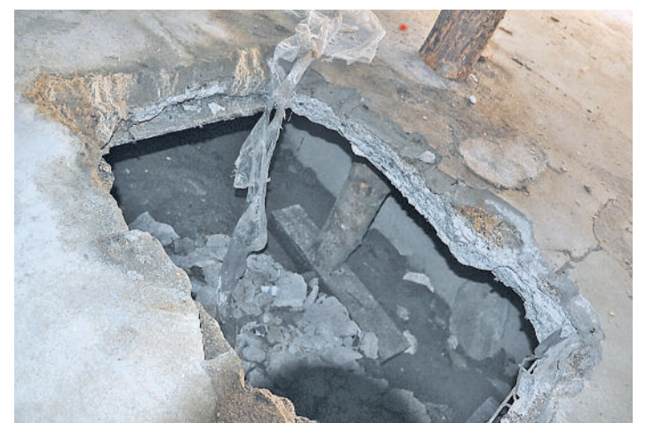
«Schtipper». Durch den Hohlboden reichende Baumstämme garantieren, dass der Bagger nicht einstürzen kann.
