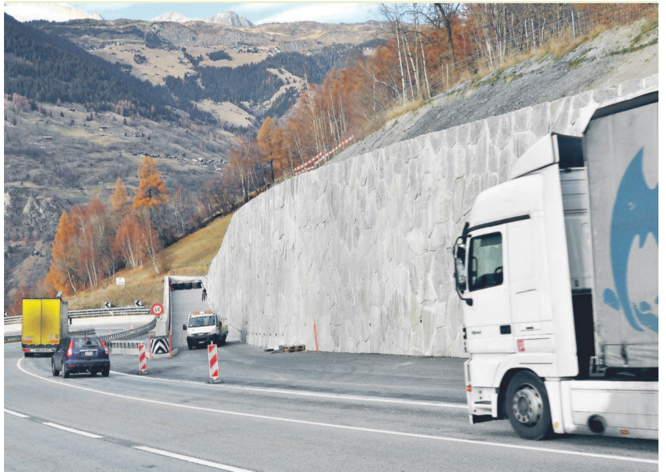
Notausfahrt. Versagen die Bremsen, bietet sich dem Lastwagenchauffeur künftig die Bremsnotspur als letzter Ausweg vor einem Aufprall in der Kurve an.
