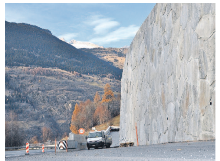
Wichtig. Das Bauwerk im Haselkehr bei Termen.
