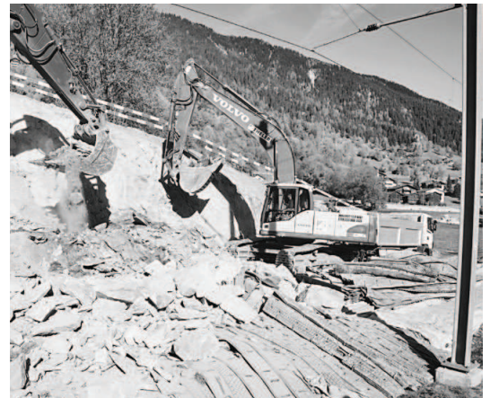
mas Sprengarbeiten. Das losgesprengte Gestein wird abtransportiert.
