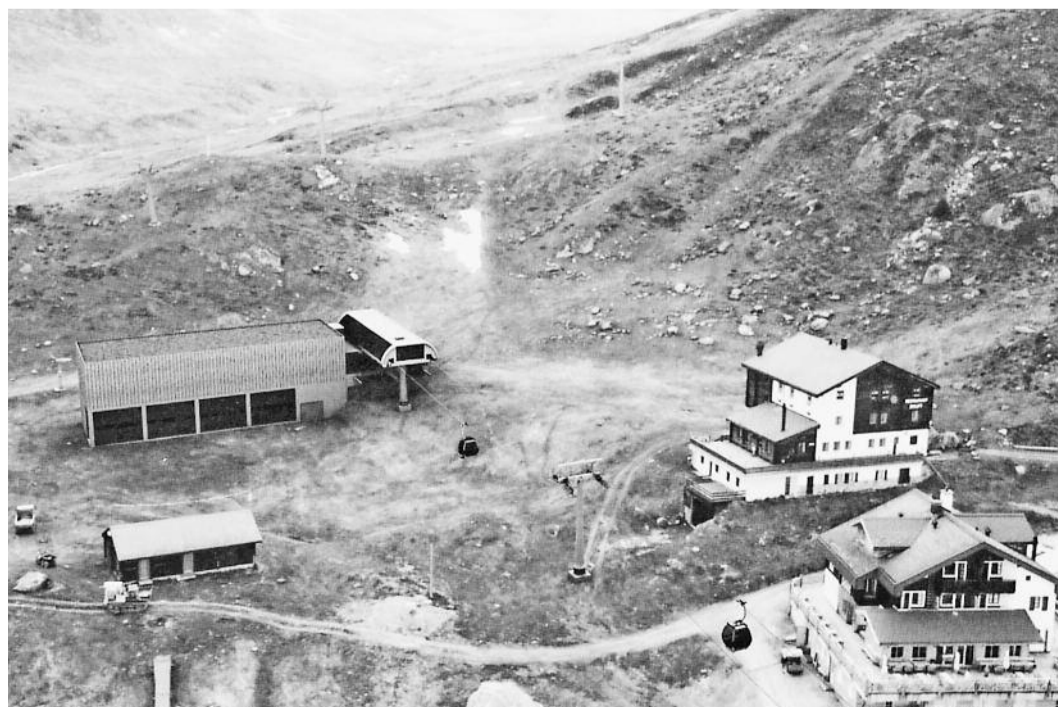
Gondelbahn Chiematta. Die Bergstation der neuen Achtergondelbahn von Blatten auf die Belalp kommt westlich des Restaurants Skilift zu stehen.
