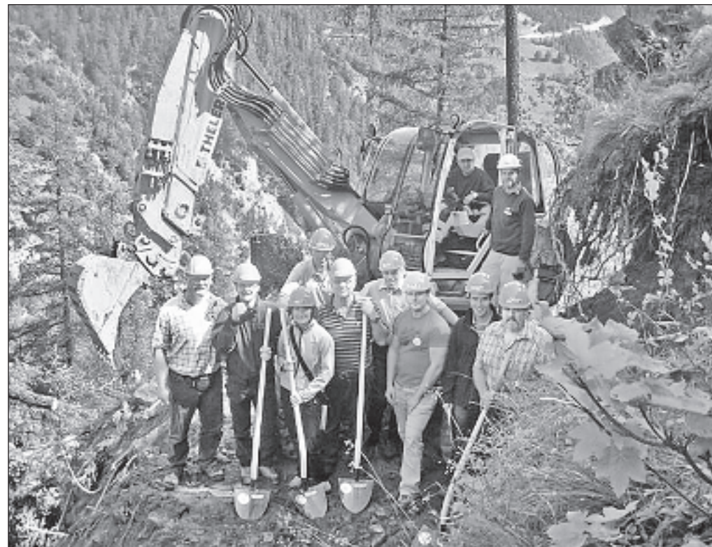
Gemeinderätin Lucia Näfen und Stadtgenieur Björn Wyss inmitten der ausführenden Unternehmer beim Spatenstich. Foto zvg
